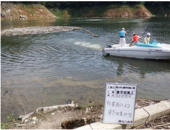
作業船による流木等回収作業 (H26. 10. 10)
