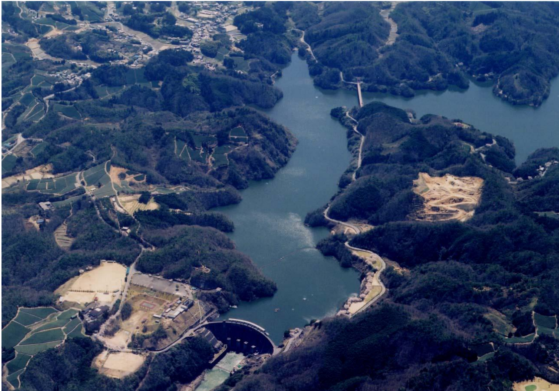
図 1. 2. 3-1 高山ダム全景
