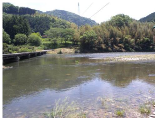
12時10分頃(有市潜没橋右岸から左岸を望む) 最大増水時
