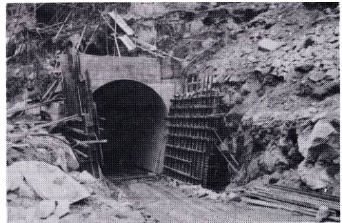
仮排水トンネル工事
