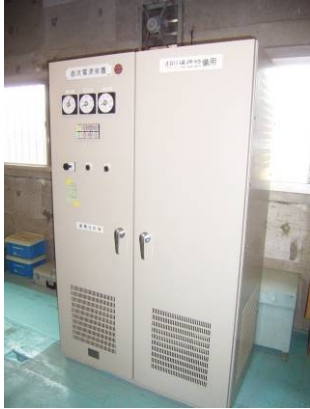
(始動用直流電源設備：施工前)
