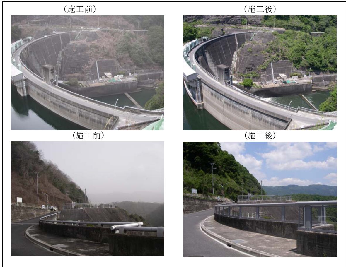
图 1.3.1-9 天端高欄整備工事(平成 18 年度)
