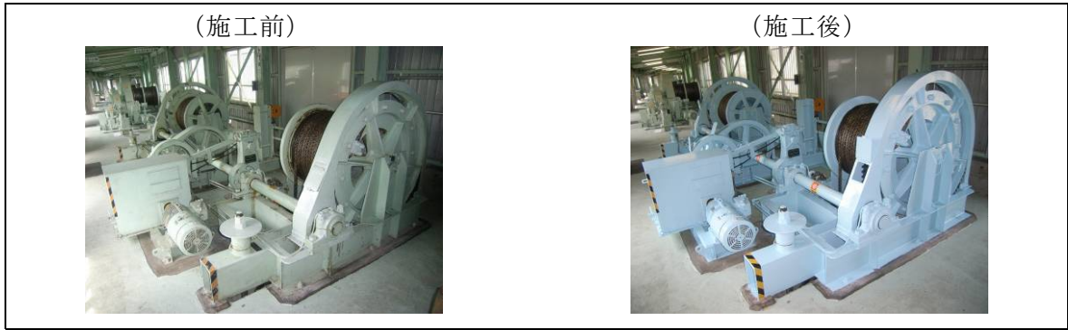
図 1.3.1-28 常用洪水吐き設備塗装(平成 20 年度)
