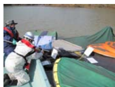
警告文設置状況
