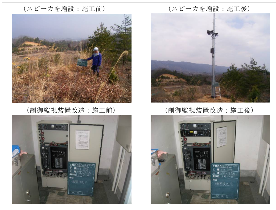
図 1.3.1-25 放流警報設備改造工事 (平成 19 年度)
