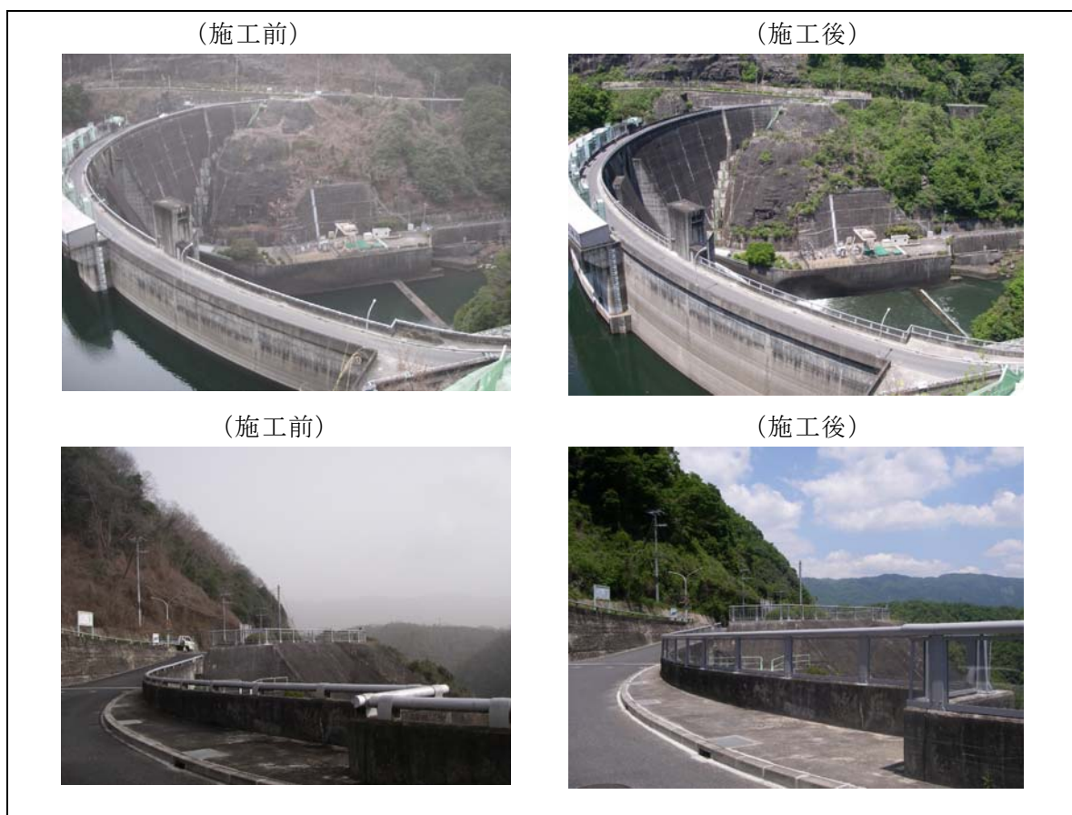
图 1.3.1-23 天端高欄整備工事(平成 19 年度)
