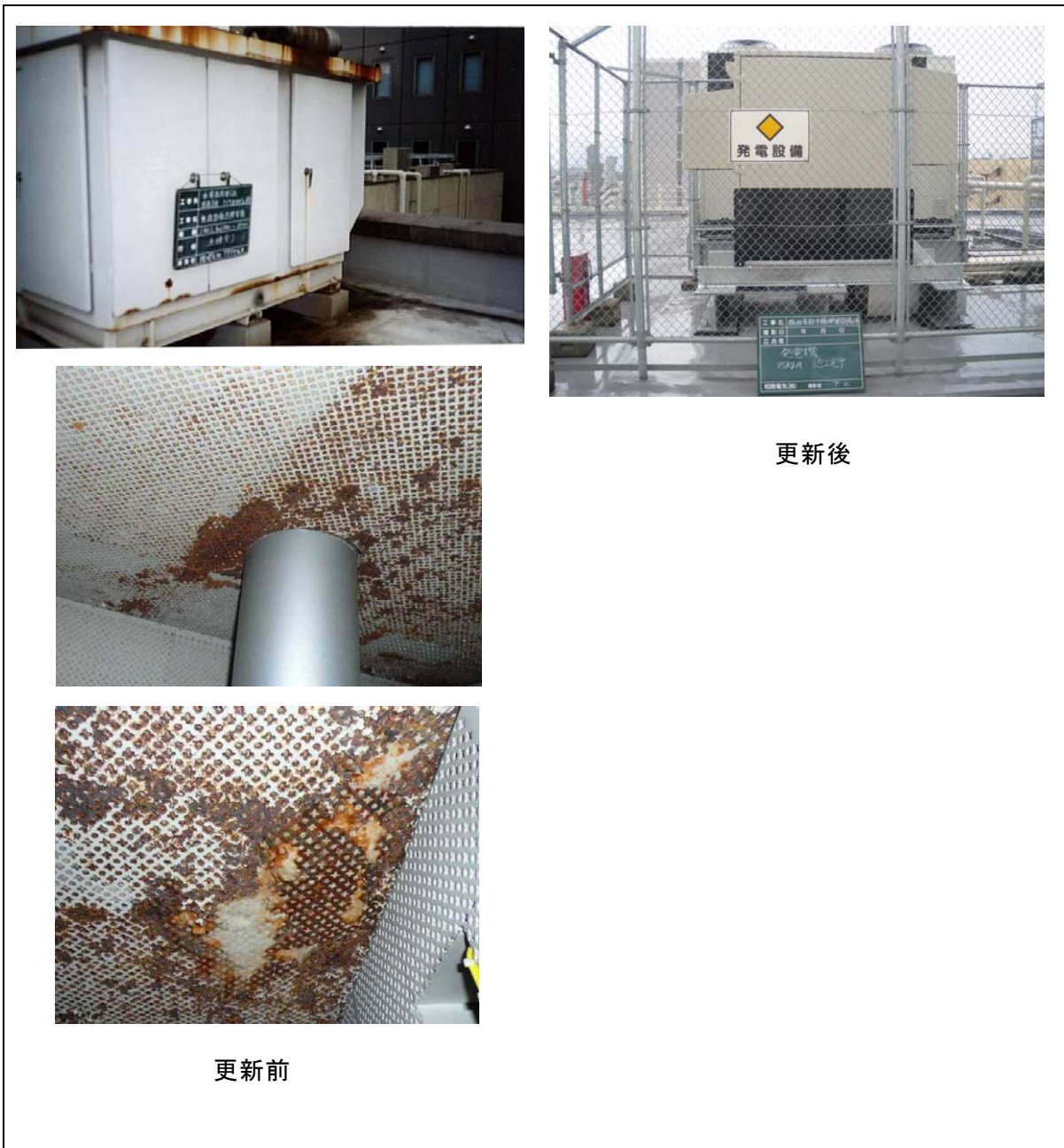
图 1.3.1-43 関西支社非常用予備発電装置更新(平成 21 年度)
