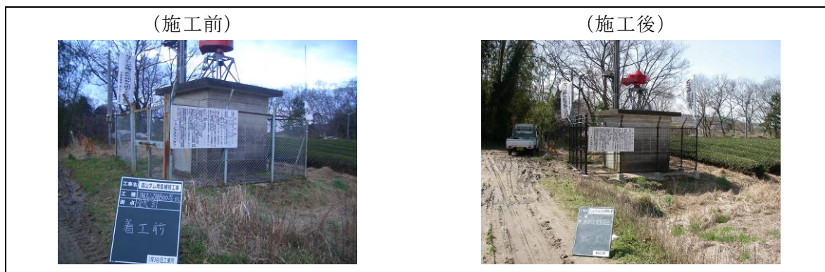
図 1. 3. 1-34 下流警報局舎補修(平成 20 年度)
