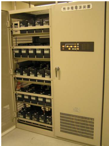
図 1.3.1-36 無停電電源設備更新(平成 20 年度)
