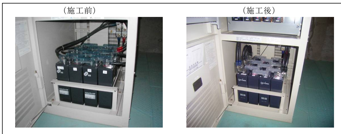
图 1.3.1-21 始動用直流電源装置整備工事(平成 19 年度)
