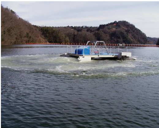
＜曝気循環設備＞
