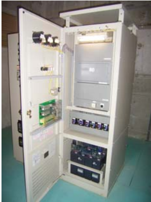
(始動用直流電源設備：施工前)
