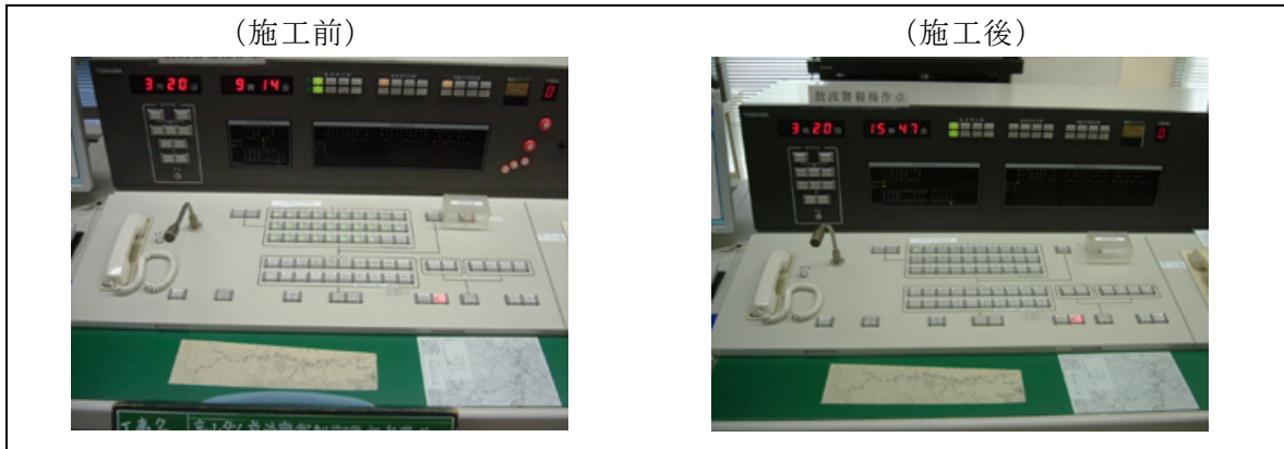
图 1.3.1-10 放流警報設備改造工事(平成 18 年度)
