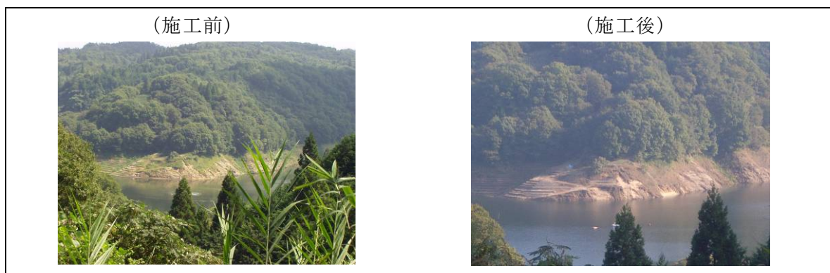
図 1.3.1-41 法面对策工事(平成 20 年度)
