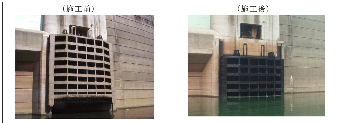
図 1.3.1-3 常用洪水吐予備ゲート塗装(平成 18 年度)
