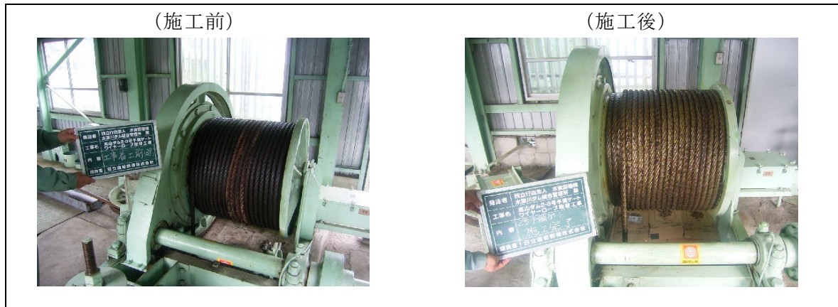
図 1.3.1-2 常用洪水吐予備ゲートワイヤロープ取替(平成 18 年度)
