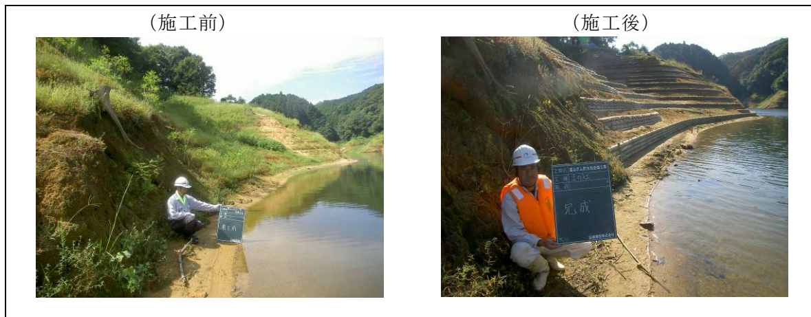
图 1.3.1-22 法面对策工事(平成 19 年度)
