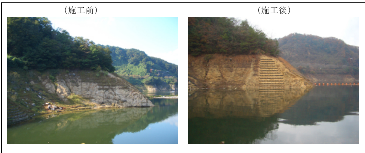
图 1.3.1-8 法面对策工事(平成 18 年度)
