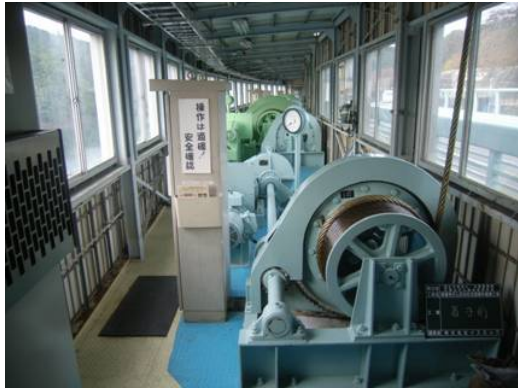
非常用ゲート整備前
