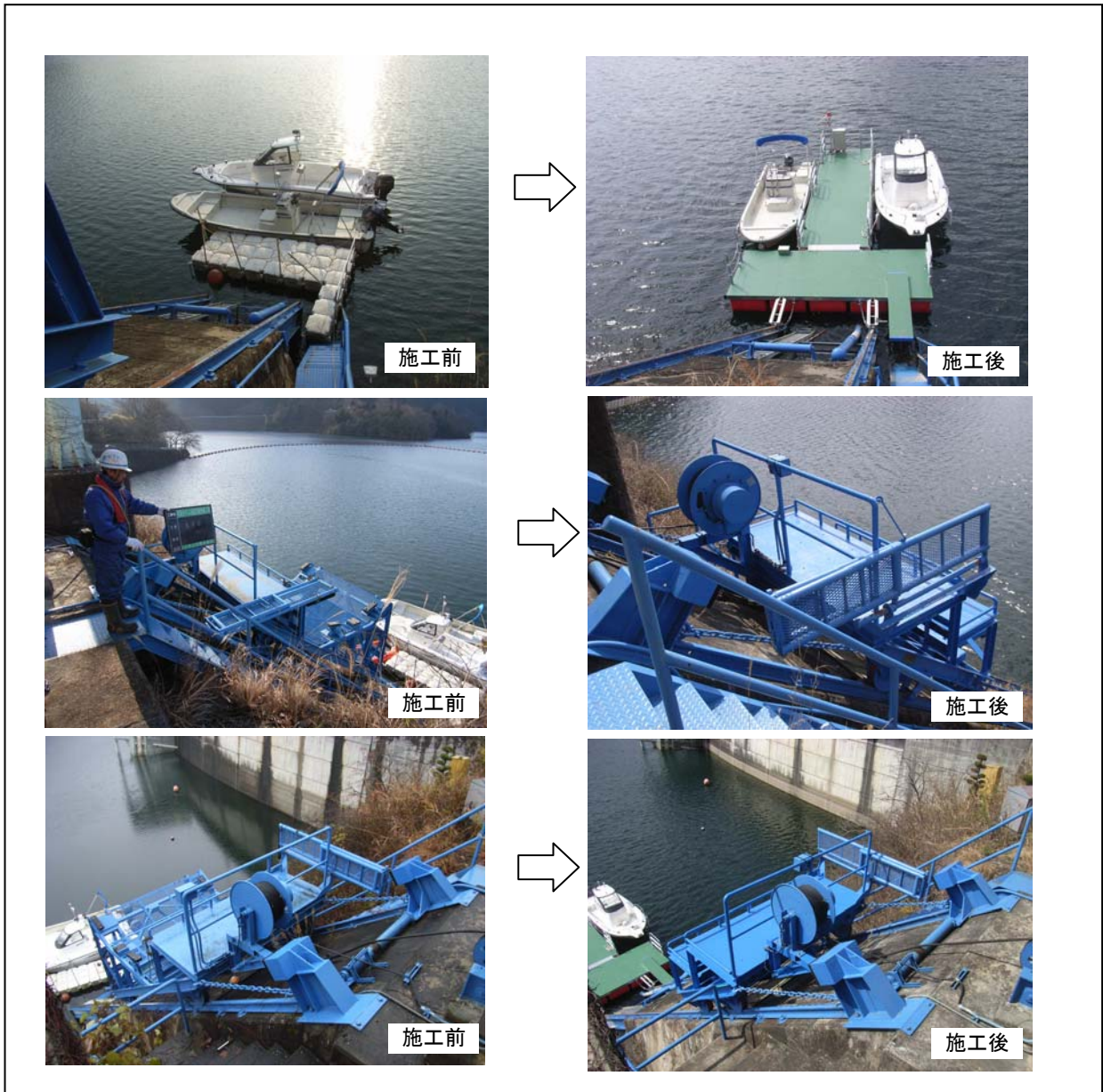
図 1.3.1-3 係船施設整備（平成 18 年度）
