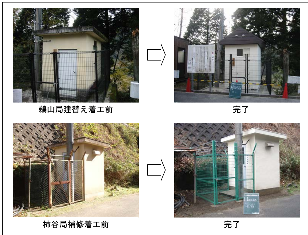
図 1.3.1-22 警報局舎改修 (平成 20 年度)
