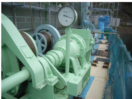
予備ゲート整備前
