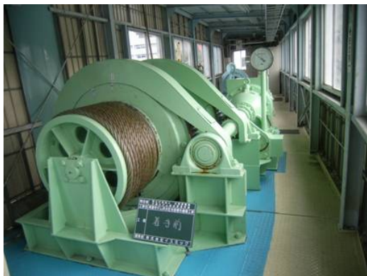
予備ゲート整備前
