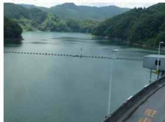
【現状】 8月5日撮影 (ダムサイト)
