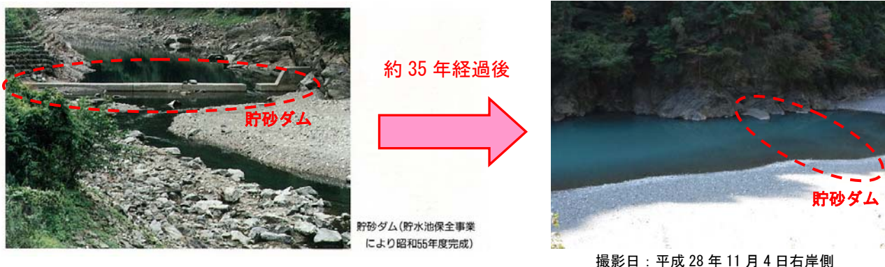
図 4.5.2-2 貯砂ダムにおける堆砂の現状
