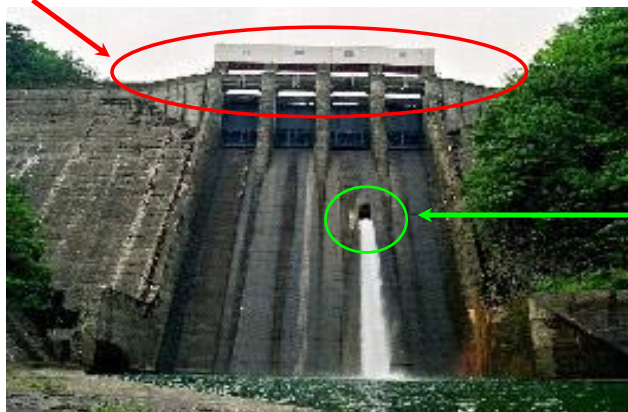
図 1.2.4-3 猿谷ダム放流設備
