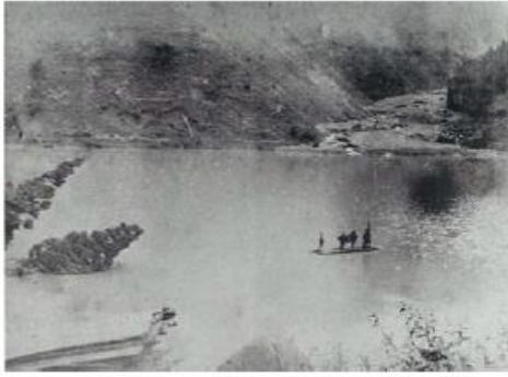
大字林山崩れ、十津川を閉塞
