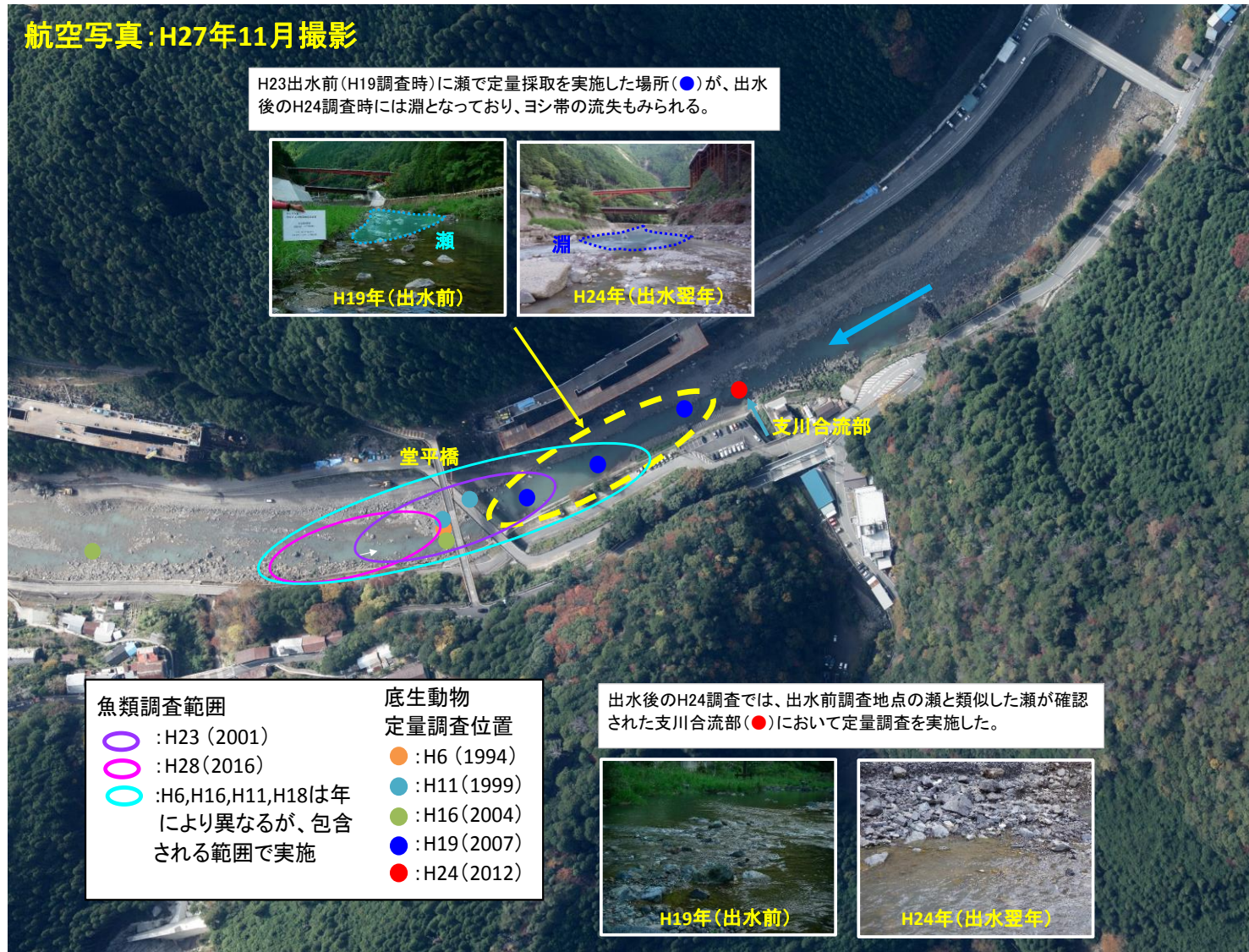
図 6.3.2-6 平成 23 年度台風 12 号の出水前後での下流河川（ダム下流 2.3k の堂平橋）の地形変化
