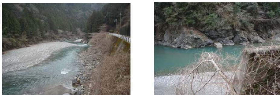
図 4.5.2-3 貯砂ダムにおける堆砂の状況（左：貯砂ダム完成時、右：貯砂ダム 平成23年3月）
