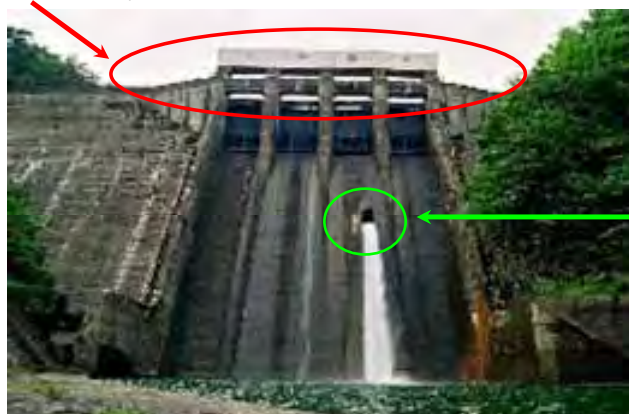
図 1.2.4-3 猿谷ダムの放流設備
