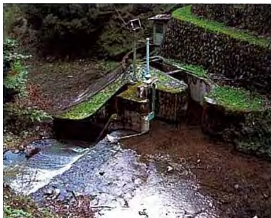
キリキ谷取水堰堤
