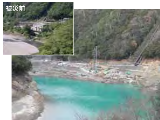
長殿発電所被災箇所
