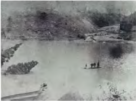
大字林山崩れ、十津川を閉塞
