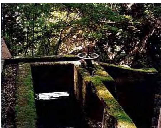
大江谷取水堰堤
