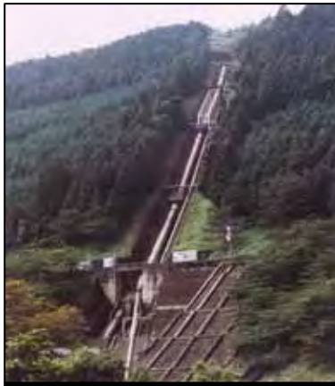
西吉野第一発電所
