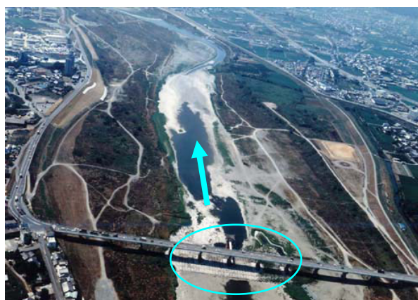
図 3.4.2-1 瀬切れ状況（平成6年8月 出橋付近）
