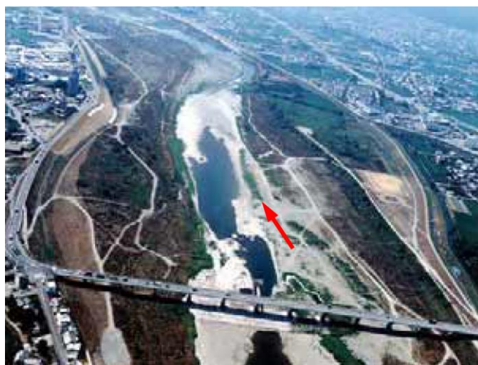
図 1. 1. 3-9 岩出橋付近の瀬切れ（平成6年8月）
