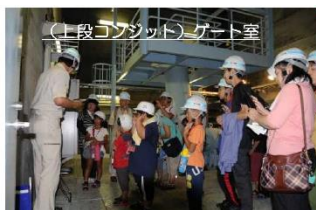
コンジットゲートからの放流についての説明を、熱心に聞き入っていました。
