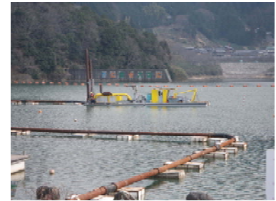
ポンプ浚渫状況 (H22)
