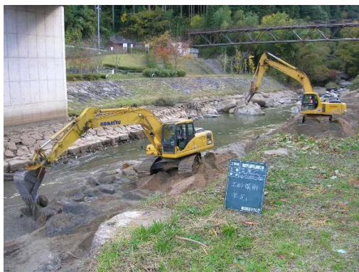
写真 堆砂掘削状況 (左：陸上掘削 右：水上掘削)
