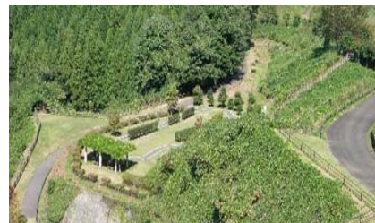
ダム右岸下流広場
