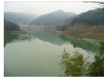
ポンプ浚渫状況(H19)
