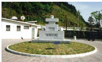
ダム左岸広場
