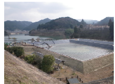
浚渫土沈殿作業 (H22)
