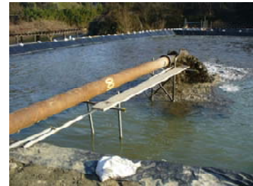
浚渫土沈殿作業(H19)
