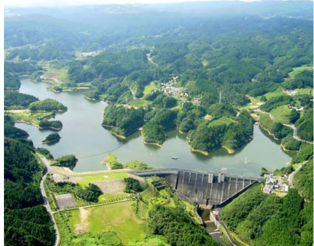
写真 6.2.2-1 布目ダム流域
