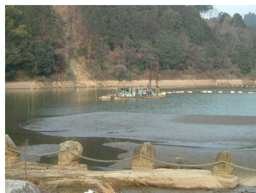
写真 堆砂掘削状況 (左：陸上掘削 右：水上掘削)
