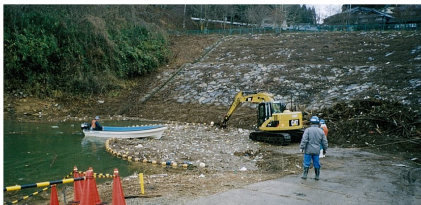
図 2.6-3 流木塵芥等揚陸状況
