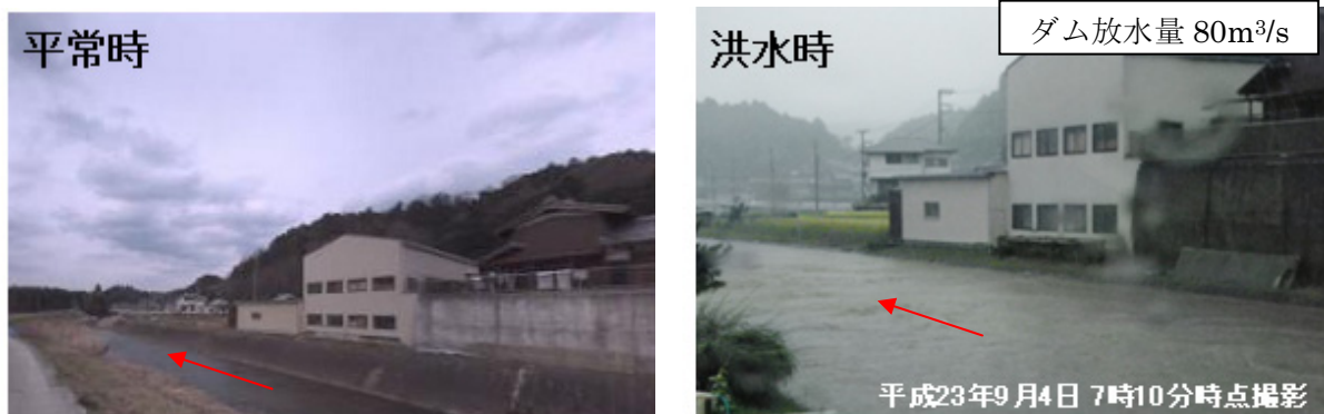
■平成 23 年 9 月 4 日出水の際の下流河川の状況(ダム下流 3.7km 地点)
