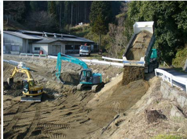
写真 4.5.3-2 道路拡幅工事への活用の状況
