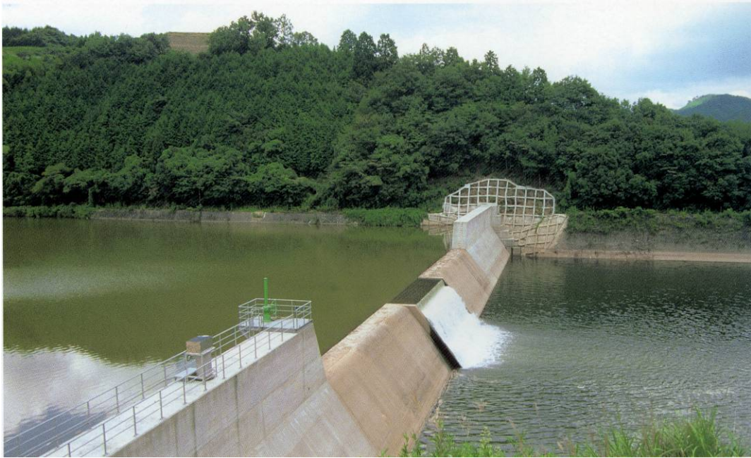
図 4.5.1-2 副ダムの設置状況
