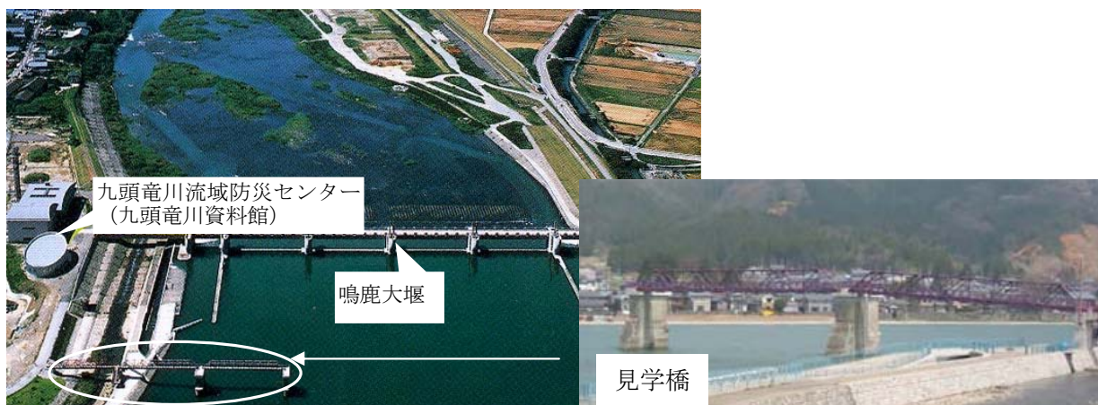
図 7.4-4 一般解放区及び見学橋の外観
