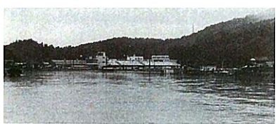
坂井郡金津町管野水口付近
