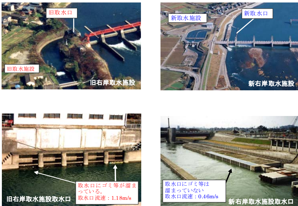
図 3.3-8 鳴鹿大堰及び鳴鹿堰堤の右岸取水施設
