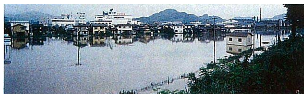
浸水状況（浅水川左岸御幸町内）
