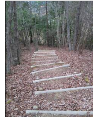
遊歩道の整備
