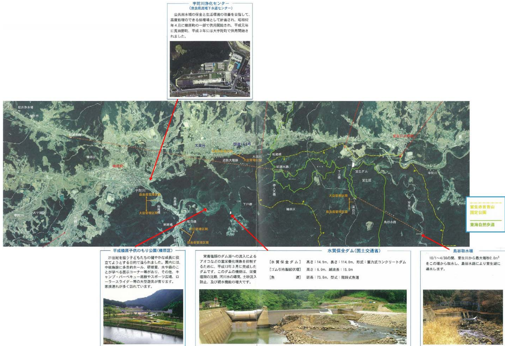
図 1.1.1-5 室生ダム貯水池流入部周辺航空写真
