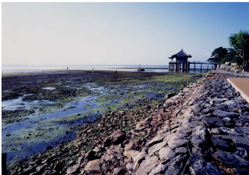
写真 1.1.3-6 浮御堂での湯水状況
