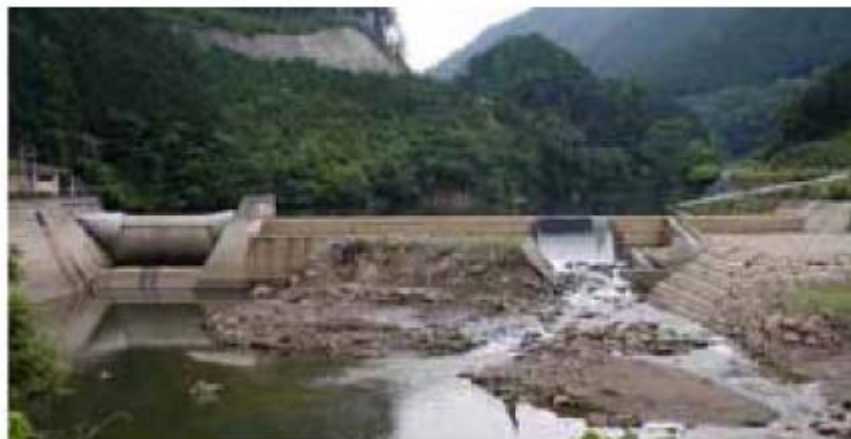
図 4.4.1-1 水質保全ダムの設置状況
