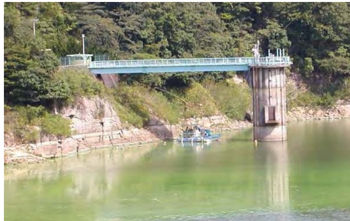
藻類処理装置設置状況(初瀬取水塔)
