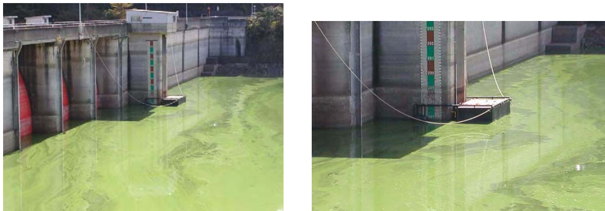
図 5.6.3-2 表面取水設備の簡易改造の現地状況
