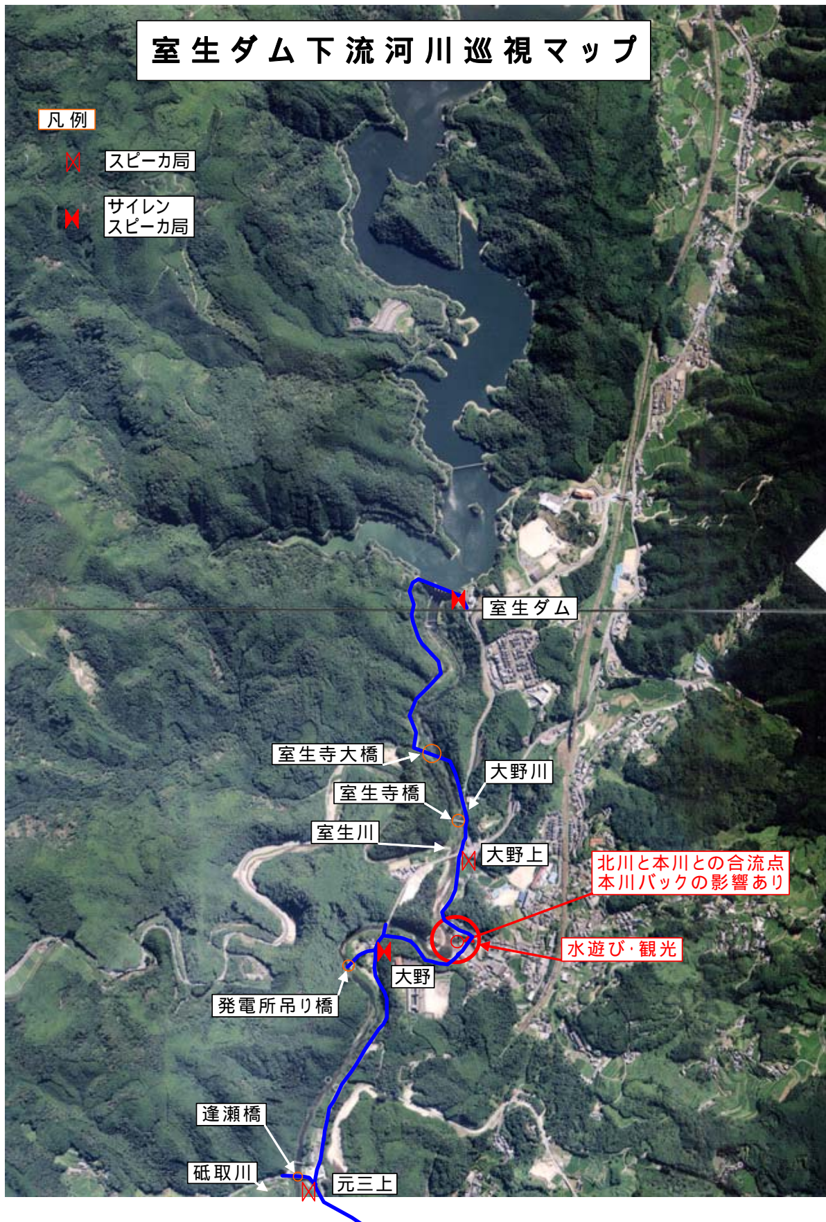
図 1.4.1-5 下流巡視経路 (1/3)
