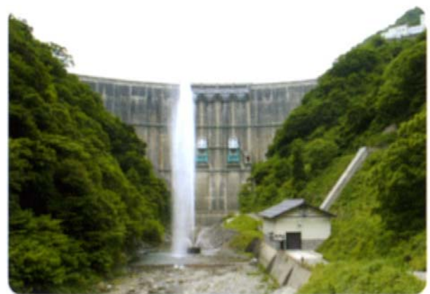
写真 3.3-2 噴水によるダム直下放流の様子
