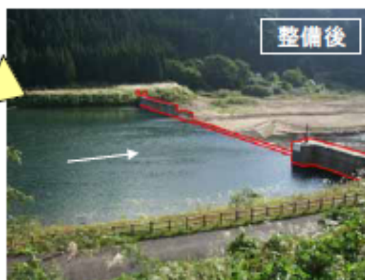
図 5.6-2(4) 事業実施状況（上半原地区：水質対策堰堤）
