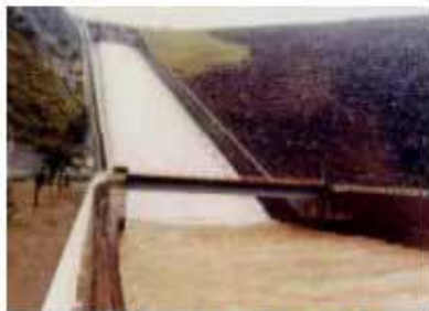
昭和 51 年の台風 17 号による洪水吐ゲートからの放流状況
