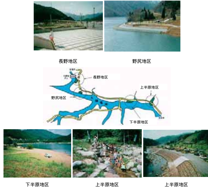
図 6.3-6 九頭竜ダム周辺環境整備事業における各地区の整備状況
