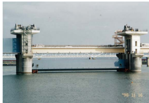
主ゲートの据付
