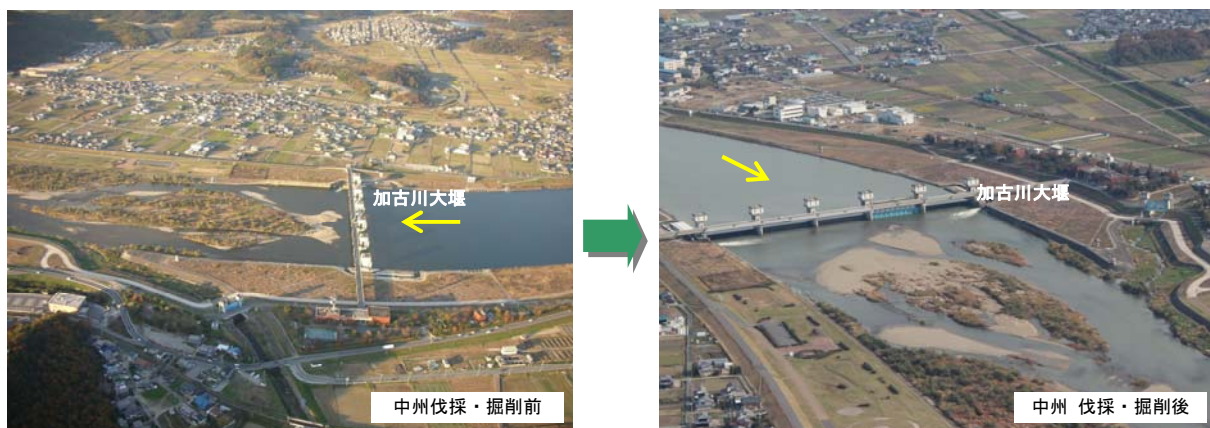
写真 4.2-1 堰直下の現状
