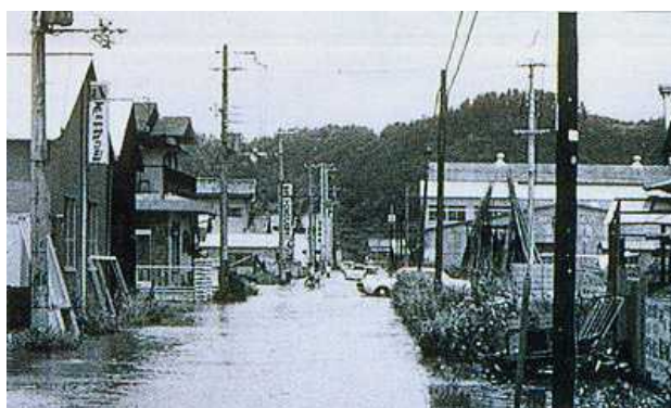
昭和49年7月 台風8号による水害の状況
