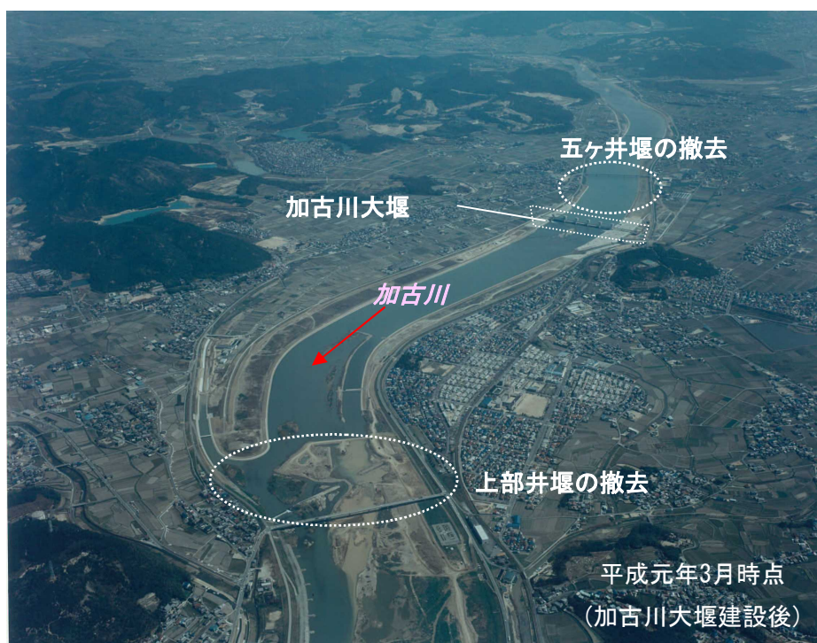
図1.2-3 井堰の統合の状況
