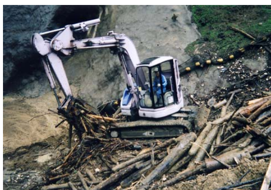
流木処理状況（近景）
