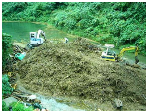
流木処理状況（遠景）
