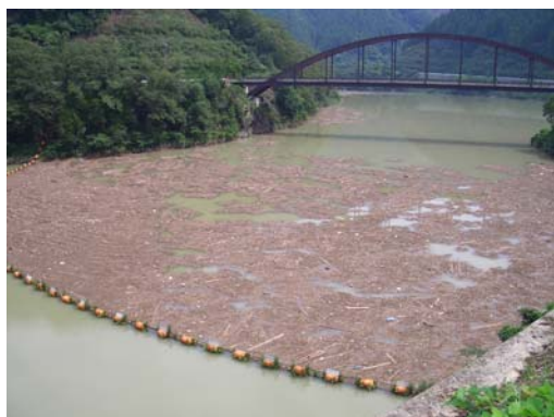
流木発生状況
