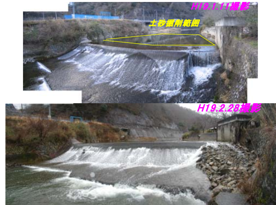
写真 6. 5. 2-2 貯水池上流(一庫大路次川)旧堰堤での土砂掘削 (左:位置図、右:掘削前後の様子)
