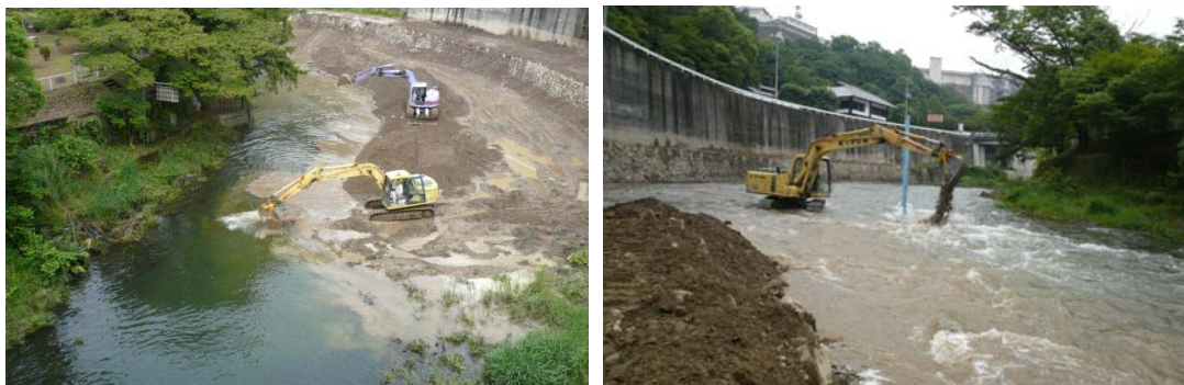
写真 6. 5. 2-3 平成 20 年のフラッシュ放流状況
