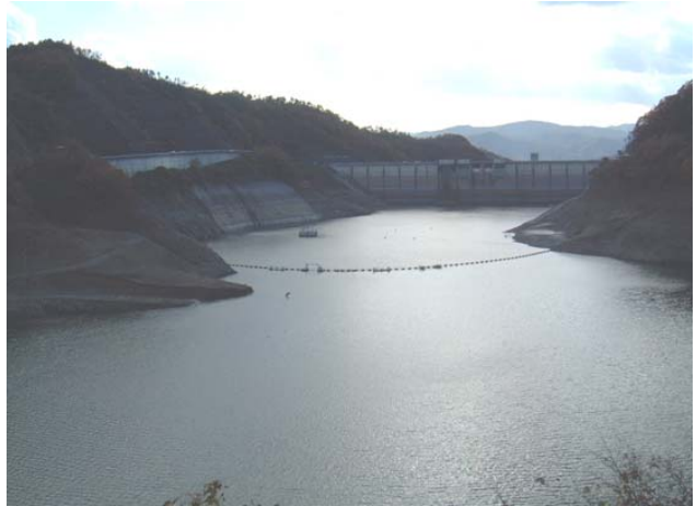
写真 ダム貯水池
