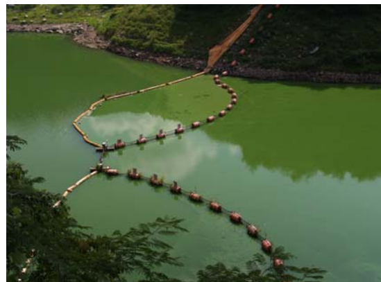
写真2 上流側分画フェンス付近
