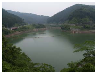
写真3 分画フェンス下流付近
