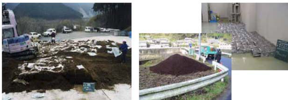
流木を破碎後、堆肥化
