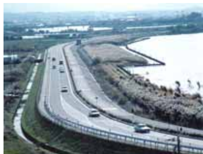
湖岸堤と前浜（植栽されたヨシ帯）
