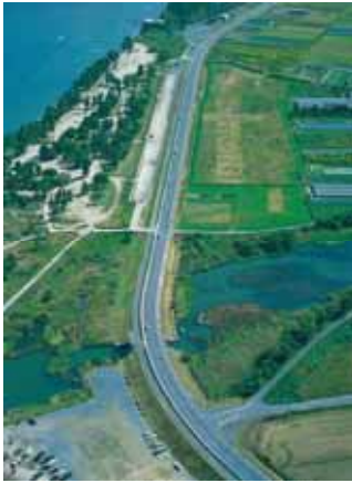
(a) 湖岸堤の建設
