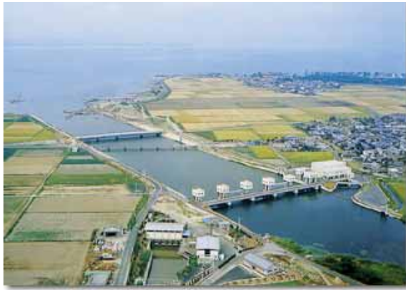
(b) 内水排除施設
