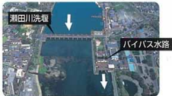
(f) 瀬田川洗堰の改築
