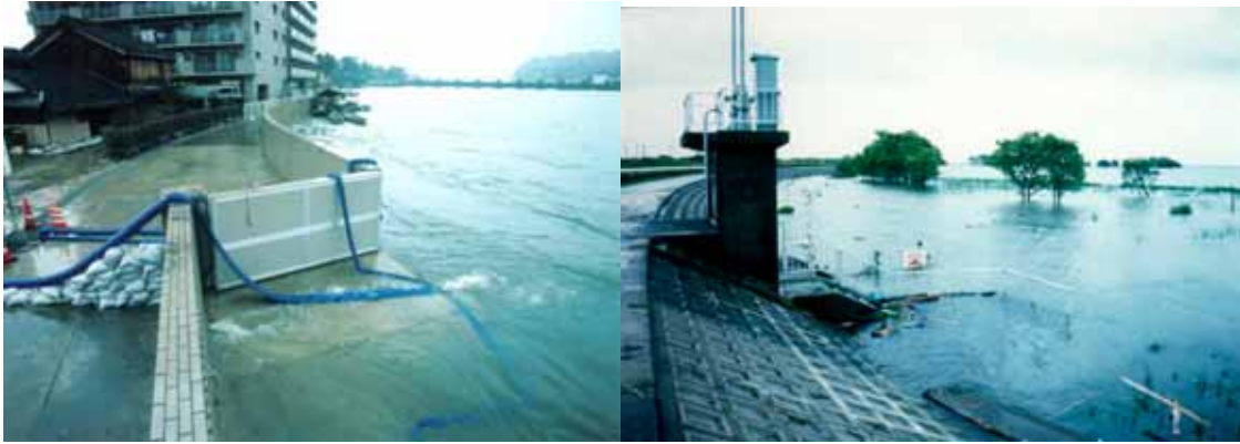
写真 2.4-1 平成 7 年洪水による浸水状況（左：南郷、右：湖北町）
