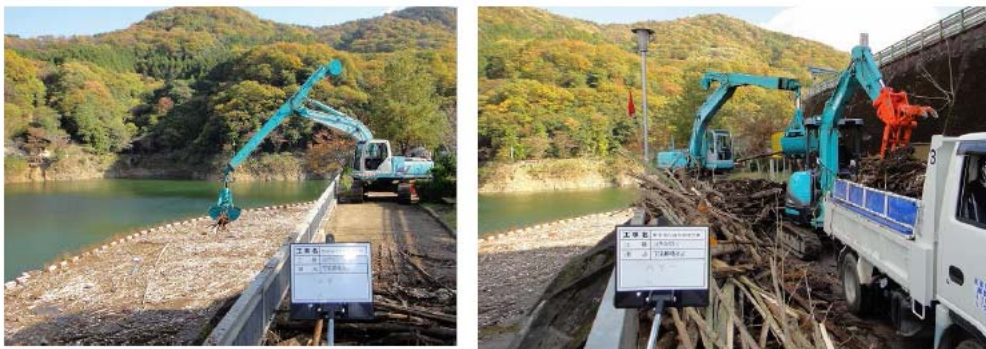
図 2.4-11 流芥の改修状況（下流網場付近）
