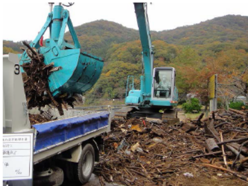
図 2.4-12 流芥の陸上げ作業（下流網場付近）
