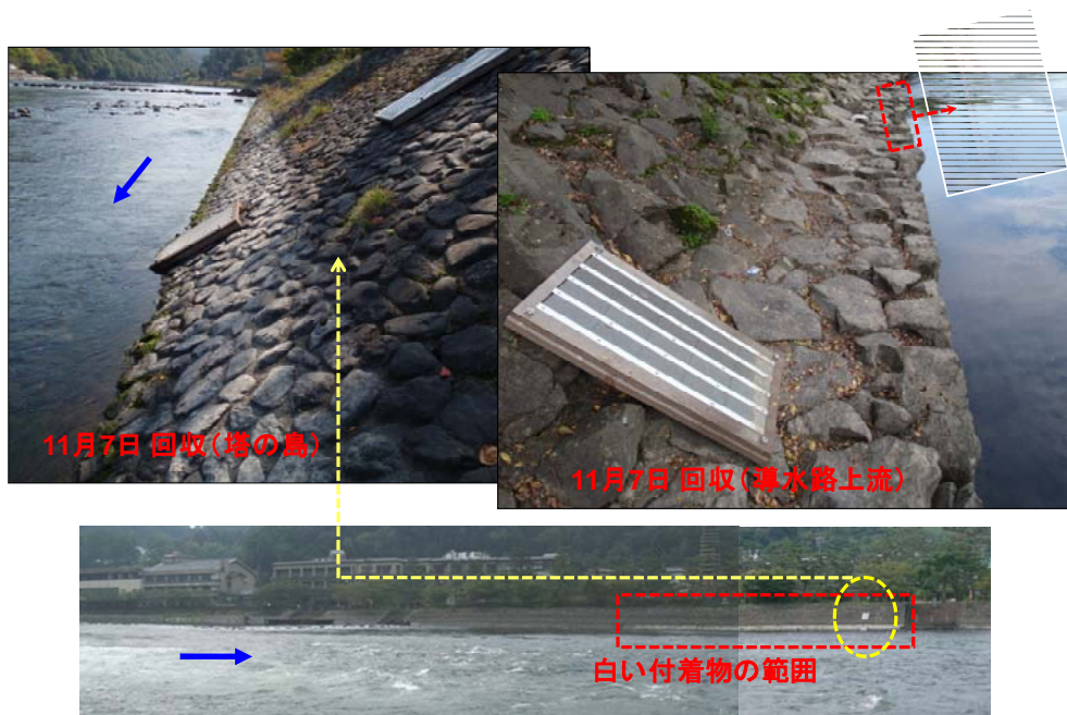
図 5.3-56 付着板設置状況
