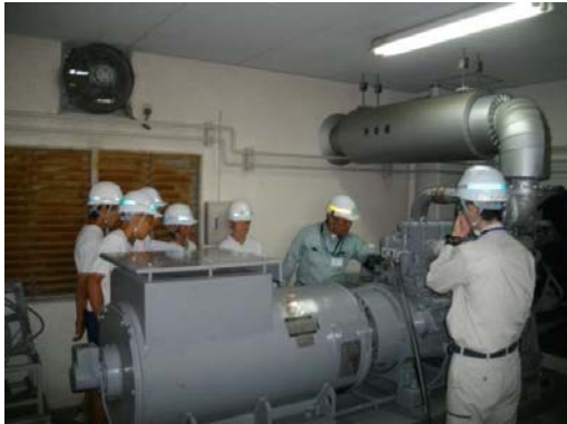
ダム本体の点検
