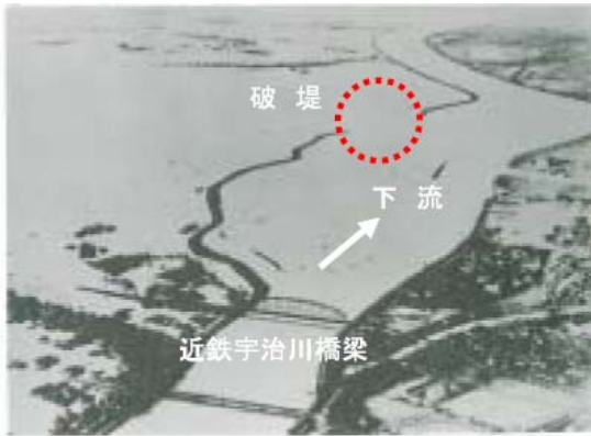
図 1.1-18 破堤状況
