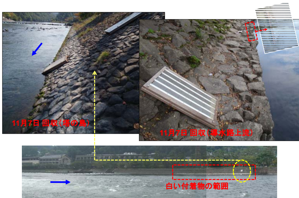
図 5.3-45 付着板設置状況
