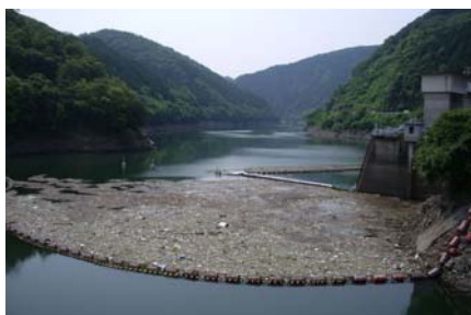
図 2.3-12 天ヶ瀬ダムの網場で捕捉される流芥
