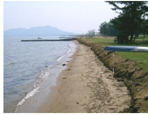
b) 2号突堤より西側の状況
