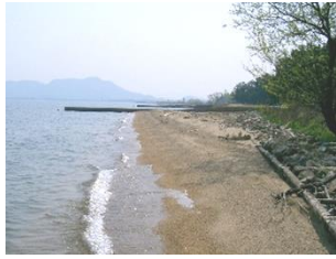
a) 1号突堤より西側の状況
