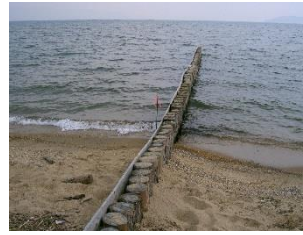
c) 3号突堤の状況
