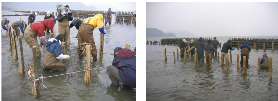
イベントによりヨシの植栽を実施 (2008年 (平成20年) 2月23日施工)
