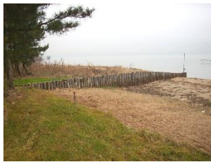
d) 1号突堤の改良状況
