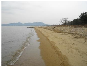
i) 3号突堤より西側の状況
