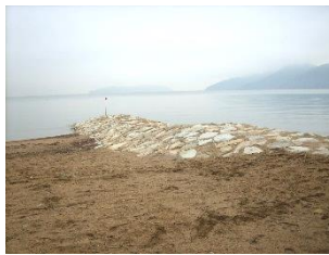
f) 3号突堤の本設状況
