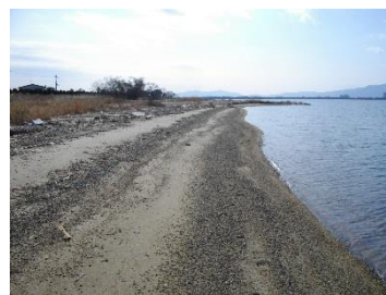
b) 2号突堤より北側の状況
