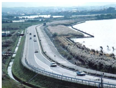
湖岸堤と前浜（植栽されたヨシ帯）
