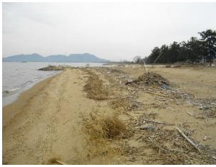
h) 2号突堤より西側の状況
