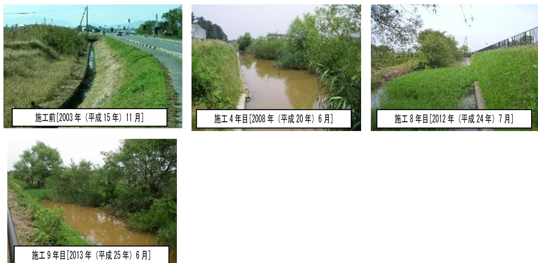
図 6.3.2-17 吉川堤脚水路の経年変化
