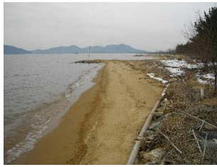
g) 1号突堤の本設状況 ：H21.11
