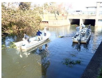
図 6.3.2-53 駆除作業の状況（針江排水機場）
