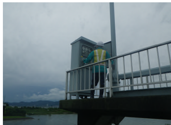
志那第1樋門周辺
