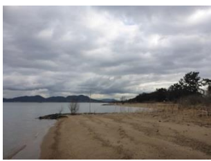
j) 1号突堤より西側の状況
