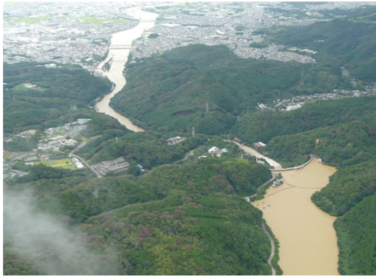
写真 2.5.2-1 天ヶ瀬ダムと宇治市街地 2013年(平成25年)9月出水による状況
