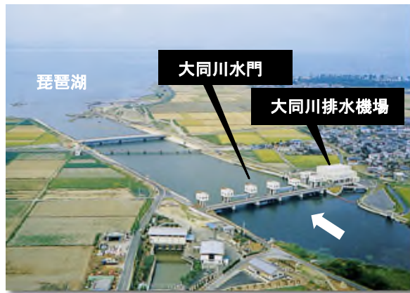
2) 内水排除施設
