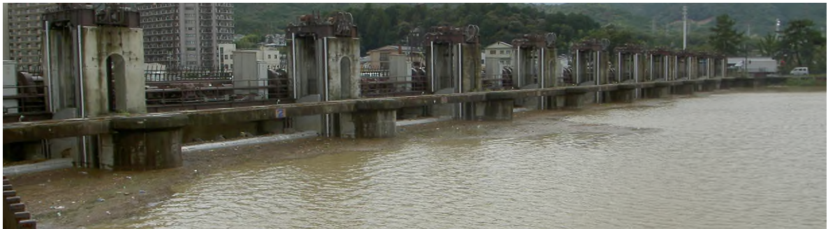
写真 2.5.2-2 瀬田川洗堰全閉状況（上流左岸より）2013年(平成25年)9月出水による状況
