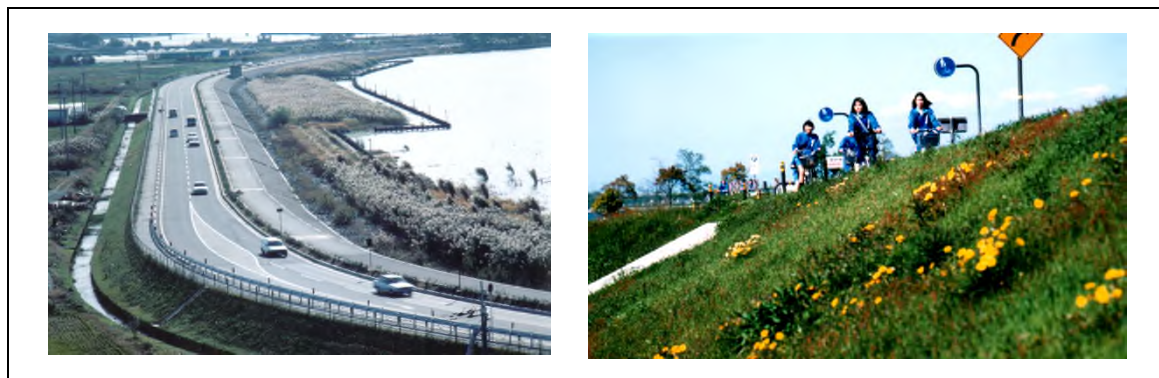
図 7.4.1-14 湖岸堤・管理用道路の利用状況
