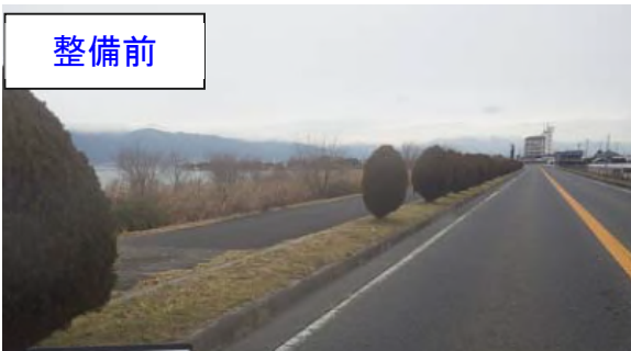
湖岸道路の現状
