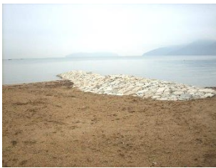
e) 2号突堤の本設状況
