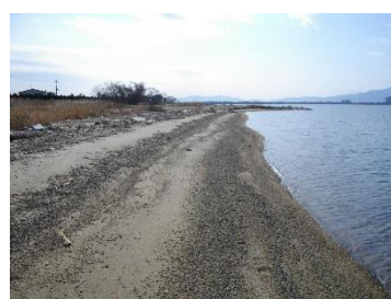
b) 2号突堤より北側の状況
