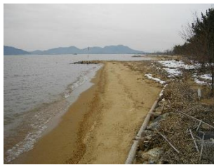
g) 1号突堤の本設状況 ：H21.11
