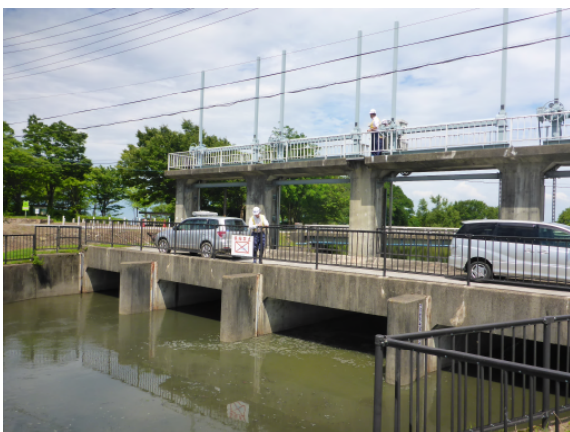
来向川樋門周辺
