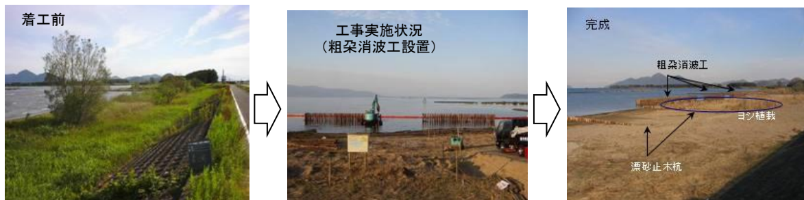
粗朶消波工とヨシの植栽により地盤の安定化を行う (2007年(平成19年)12月時点)
