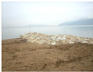
f) 3号突堤の本設状況
