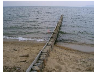
c) 3号突堤の状況
