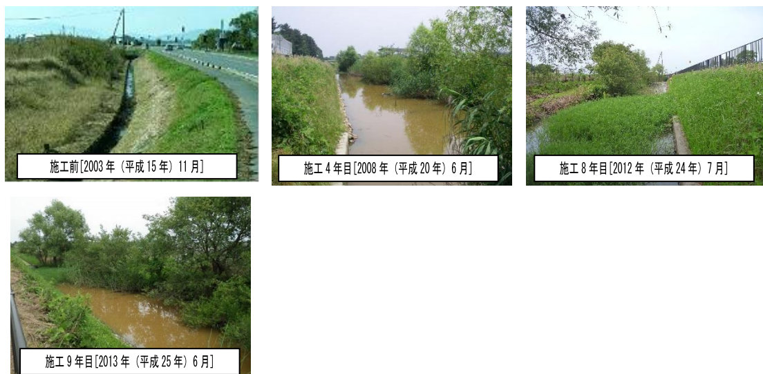
図 6.3.2-17 吉川堤脚水路の経年変化
