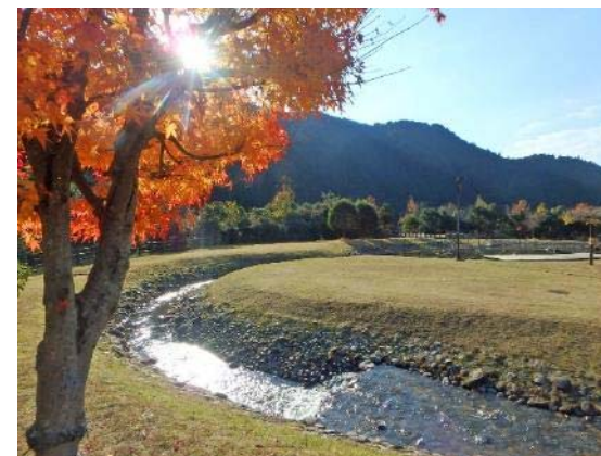
ダム下流公園の せせらぎ水路
