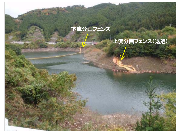
1条設置状況(上流分画フェンス退避状況)
