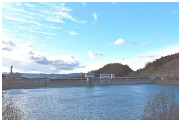
上流側からの堤体と湖面
