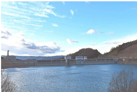
上流側からの堤体と湖面
