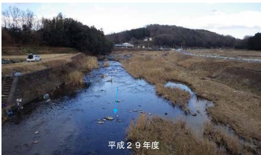
図 6.5.1-9 経年状況写真 (St. 2 四間橋)
