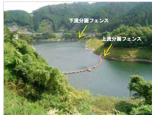
1条設置状況(上流分画フェンス退避状況)
