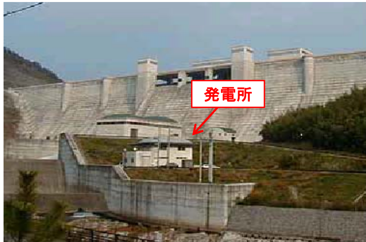
図 3.2.7-1 比奈知発電所
