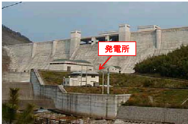
図 3.2.7-1 比奈知発電所
