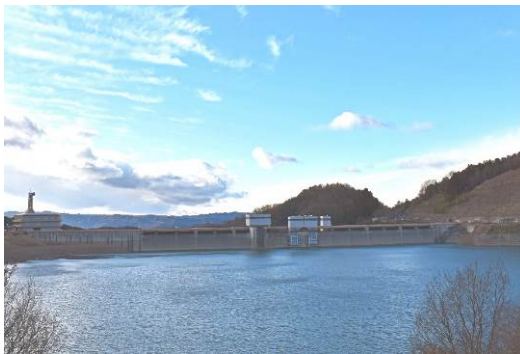
上流側からの堤体と湖面
