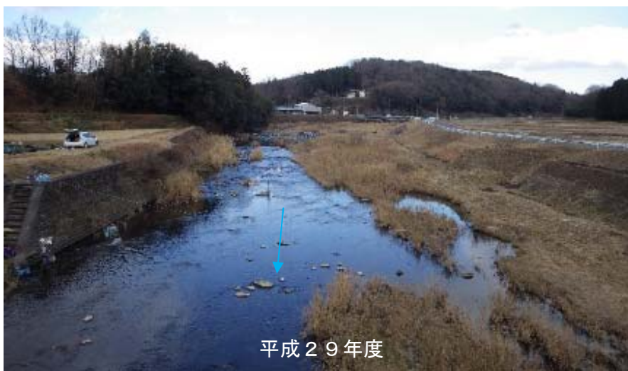
図 6.5.1-9 経年状況写真 (St. 2 四間橋)
