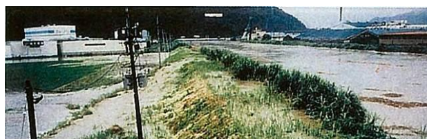
堤防からあふれ出す状況（浅水川右岸 JR 北陸本線下流付近）
