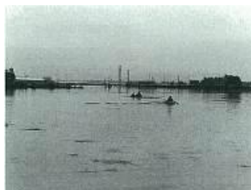
坂井市三国町下西付近の浸水状況
