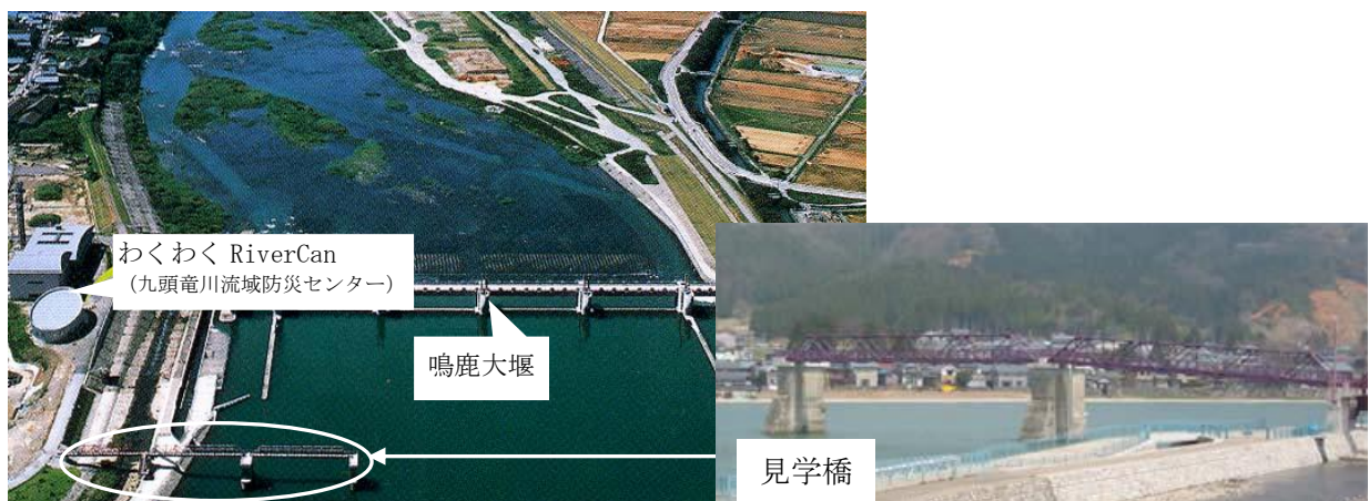
図 7.4-4 一般解放区及び見学橋の外観
