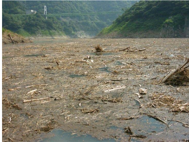
図 2.4-7 真名川ダムの貯水池に溜まっている流木の状況（若生子橋下流付近）
