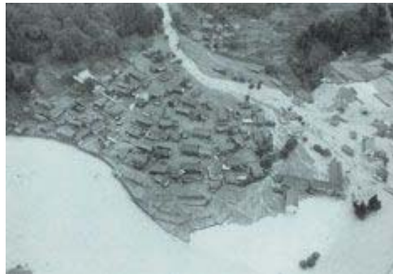
西谷村の被害状況
