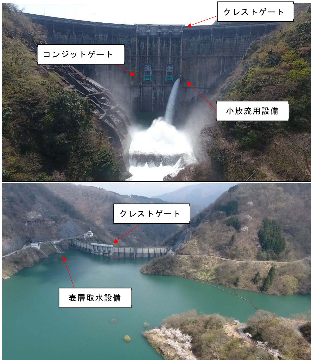
図 1.2-8 真名川ダム取水・放流設備
