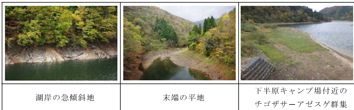
写真 6.3-2 水位変動域の状況
