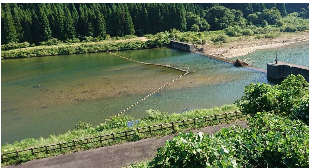
写真 4.5-1 副ダム湛水池の状況 (H30. 8月撮影)
