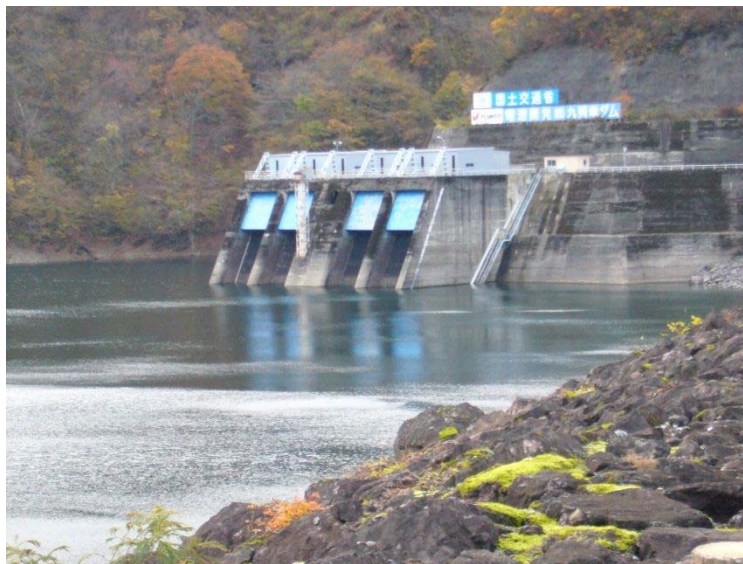
写真 3.2-2 九頭竜ダム発電取水部
