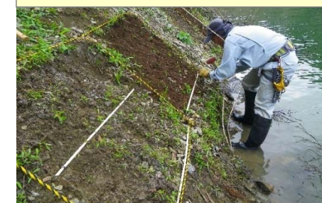
土留めの設置
