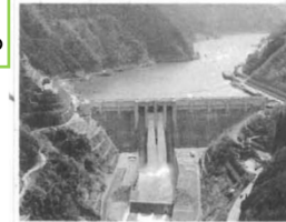
3月完成で早くも利水面で威力を発揮している大滝ダム(満瀬川)
