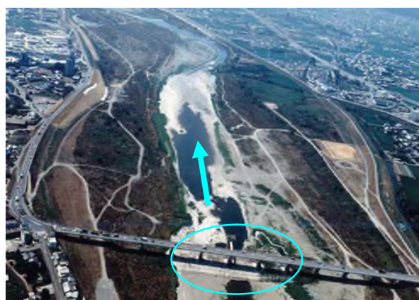
図 3.4.2-1 瀬切れ状況（平成6年8月 出橋付近）
