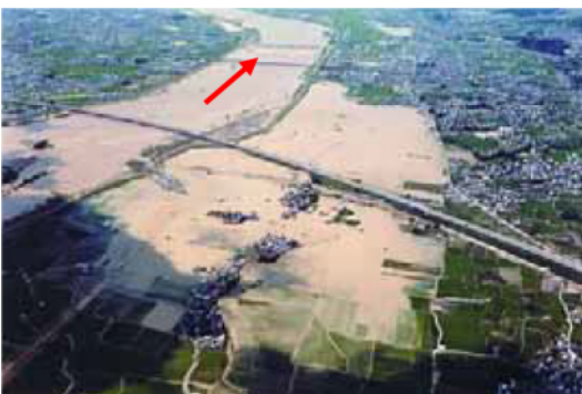
図 1.1.3-6 和歌山市直川地区の浸 水状況 (昭和 57 年台風 10 号及び台風 9 号からかわった低気圧)
