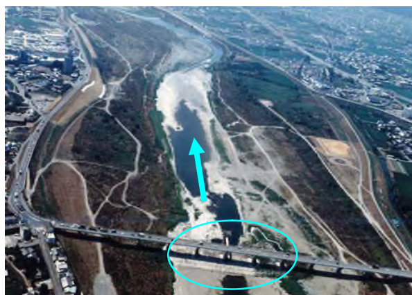
図 3.4.2-1 瀬切れ状況（平成6年8月 出橋付近）
