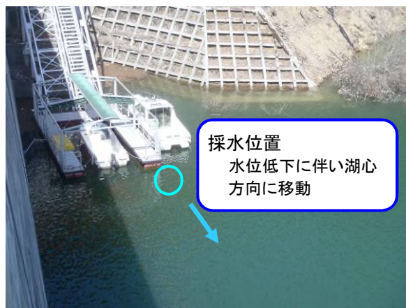
図 5.3.2-4 ダムサイト調査位置(右岸浮棧橋)
