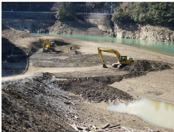
阪本取水口付近の掘削状況
