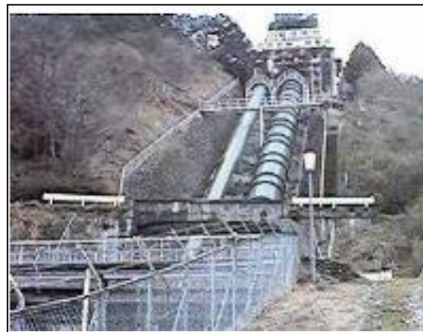
西吉野第二発電所
