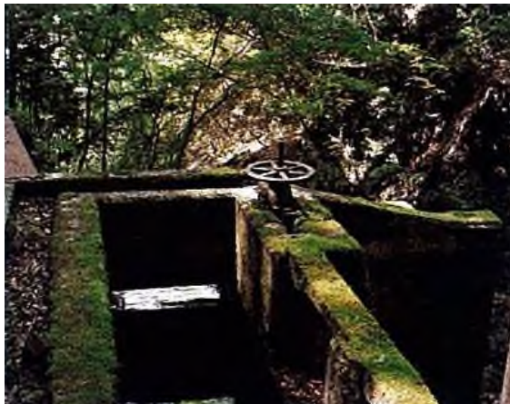
大江谷取水堰堤
