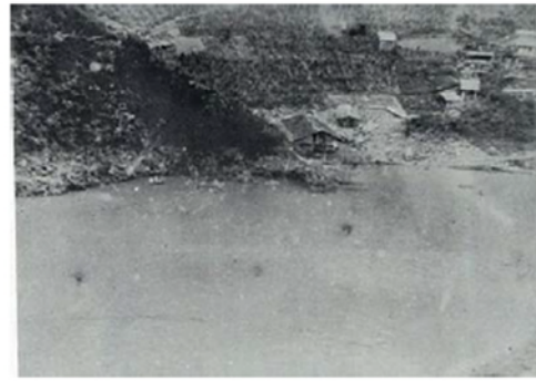
大字谷垣内山崩れ、十津川を閉塞
