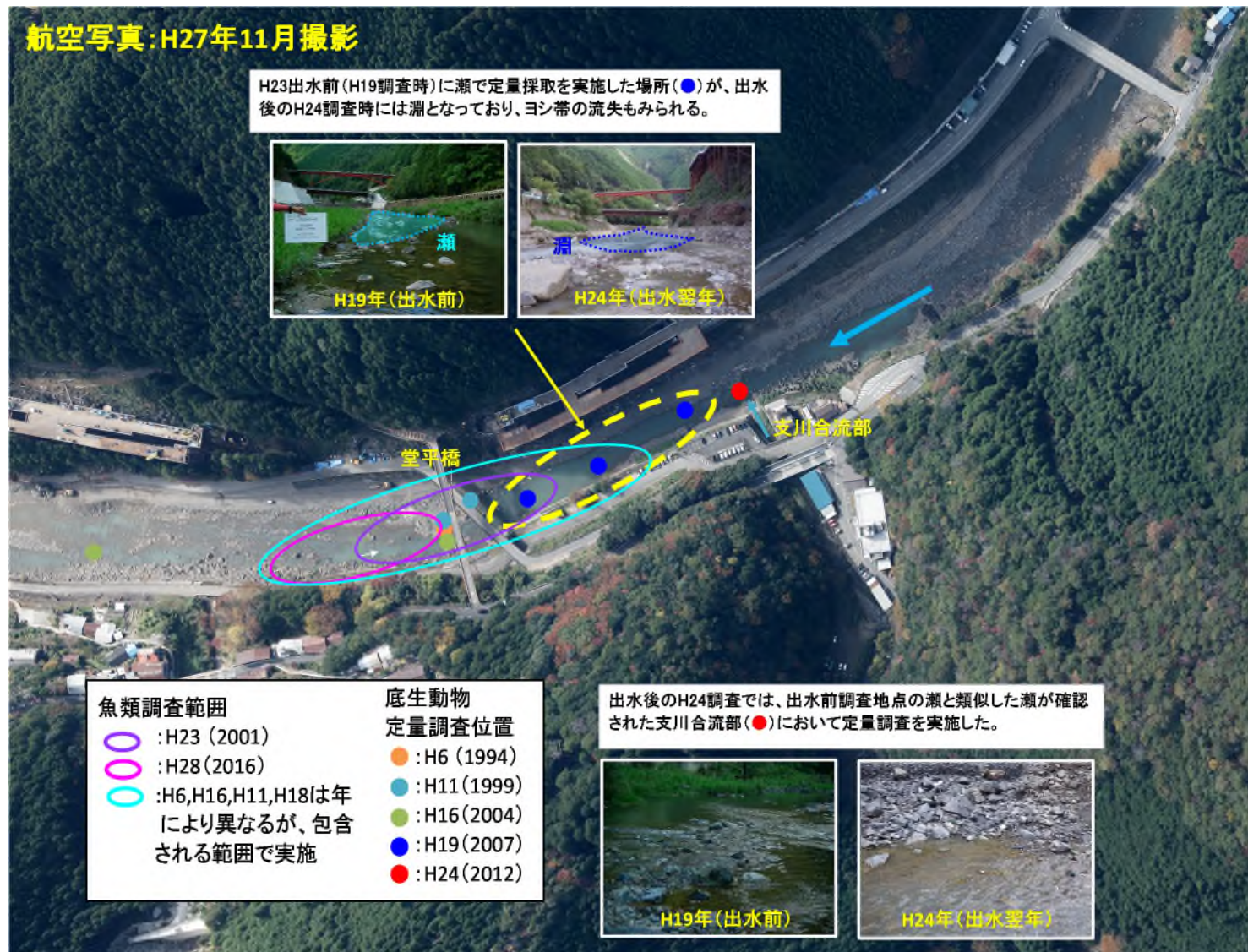
図 6.3.2-6 平成 23 年度台風 12 号の出水前後での下流河川（ダム下流 2.3k の堂平橋）の地形変化
