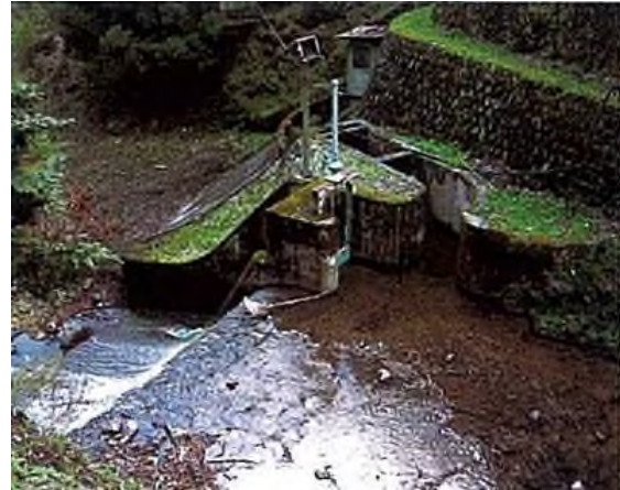
キリキ谷取水堰堤
