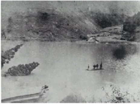
大字林山崩れ、十津川を閉塞
