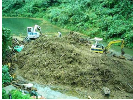
流木処理状況（遠景）
