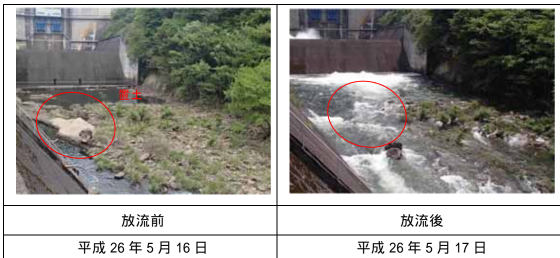
図 6.5.1-9 平成 26 年のフラッシュ放流前後の状況
