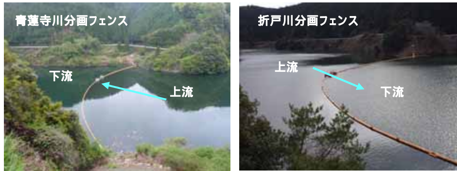
図 5.6.3-5 青蓮寺川と折戸川の分画フェンス
