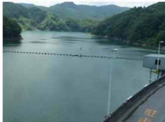
【現状】 8月5日撮影 (ダムサイト)
