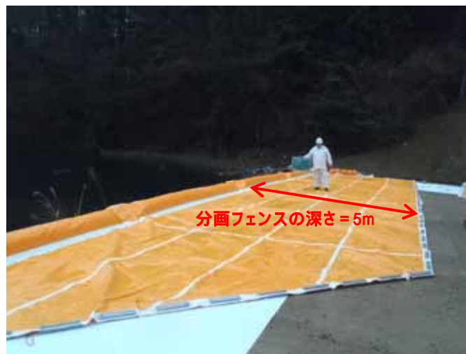
図 5.6.1-3(2) 分画フェンスの写真
