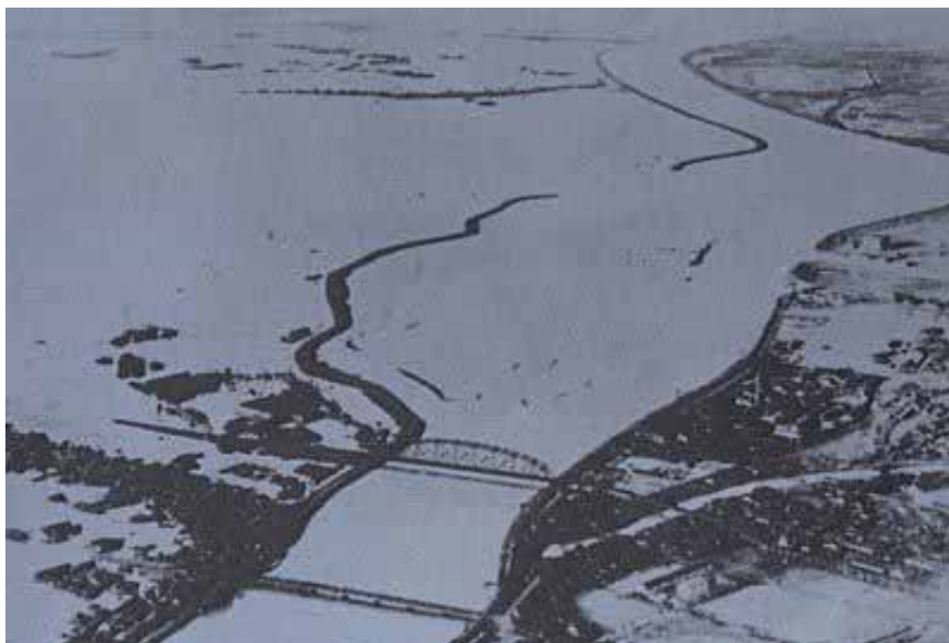
写真 1.1.3-1 久世郡久御山町での被害状況
