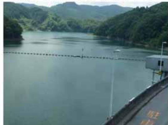
【現状】 8月5日撮影 (ダムサイト)
