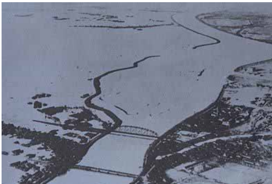
写真 1.1.3-1 久世郡久御山町での被害状況
