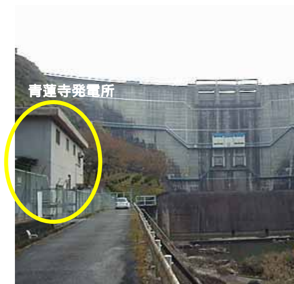
図 3.2.5-1 青蓮寺発電所
