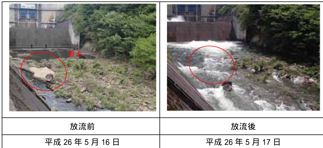
図 6.5.1-9 平成 26 年のフラッシュ放流前後の状況
