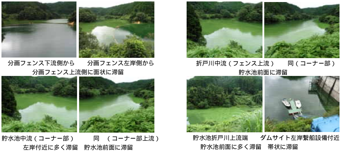
図 5.3.6-1(5) 水質障害の発生状況(平成27年9月)
