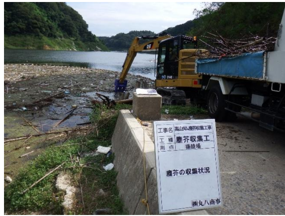
流木等の回収・陸揚げ作業 (H26. 9. 18)
