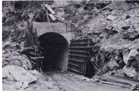
仮排水トンネル工事
